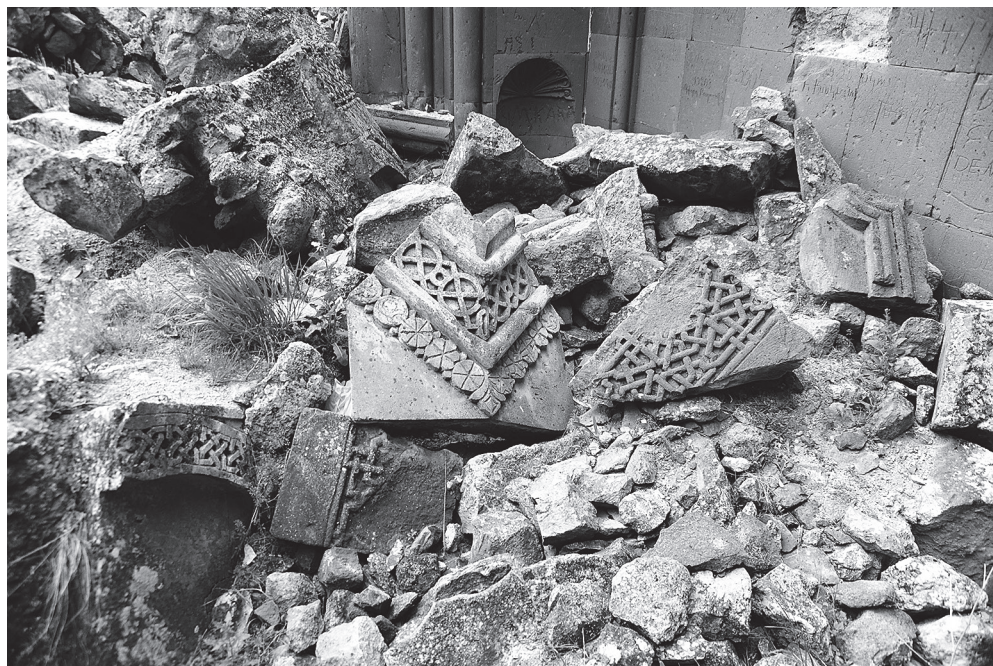
Ил. 1. Ани. Церковь во Внутренней крепости. Детали барабана и покрытия шатра в завалах фрагментов в зоне купольного квадрата. Фото автора, 2019
