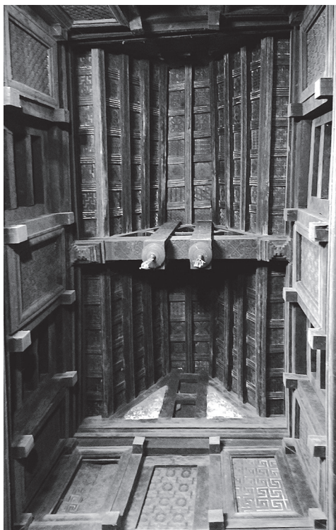
Ил. 5. Оригинальная конструкция «седловидного» перекрытия центрального нефа в церкви Йемреханна Крестос. Фото С. Ключева, 2014 г.
