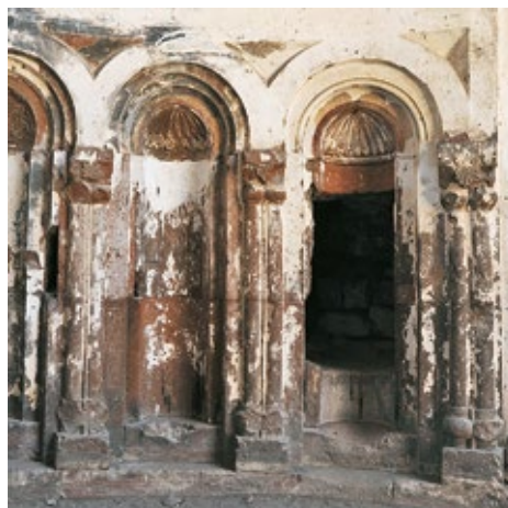
Рис. 6. Аркатура и ниши в апсиде Анийского собора. Фото А. Казаряна, 2015
