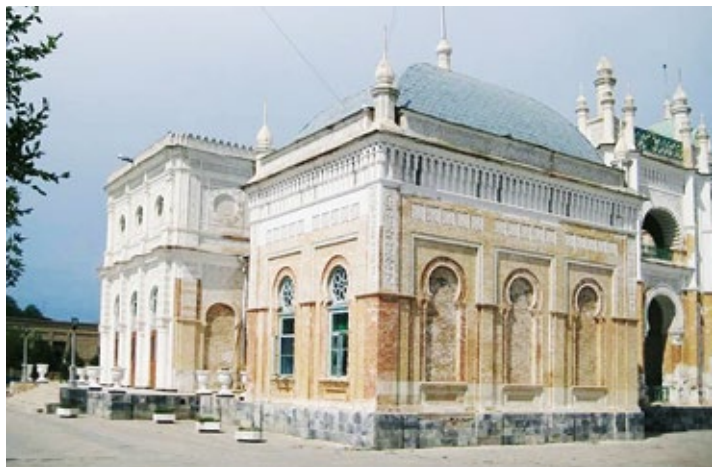
Рис. 11. Дворец эмира Бухарского в Кагане (Новой Бухаре). Архитектор А.Л. Бенуа. 1895–1898 (Дворец 1898)
