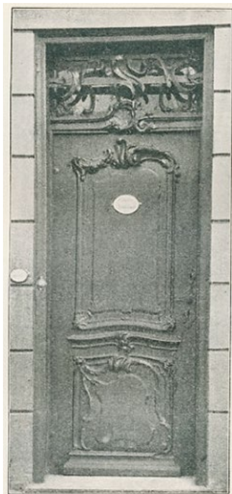
Рис. 11. Дверь на жилом доме по адресу: Бергплатц, 6, Кёнигсберг (не сохранилась). Иллюстрации (Boetticher 1897: 104)
