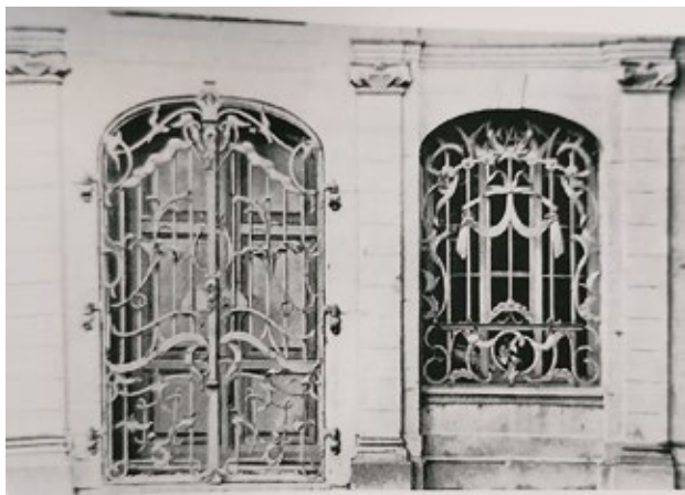
Рис. 14. Кованые дверные и оконные решетки на здании гробницы, Старое соборное кладбище на Бургенландштрассе, Кёнигсберг (не сохранились). Иллюстрация (Ulbrich 1932: S. 239)
