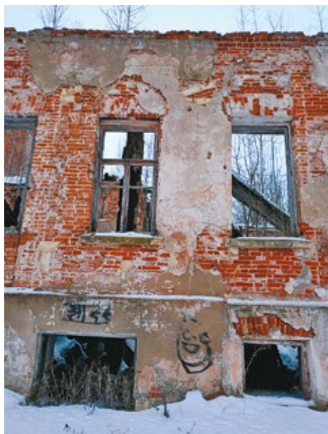
Рис. 8. Главный дом усадьбы Безобразовых. Фрагмент стены южного фасада, с закладными белокаменными деталями наличников барочного периода. Существующее состояние. Московская обл., Волоколамский район, с. Ивановское. Фото Т.В. Иванцыка, 2023 г.
