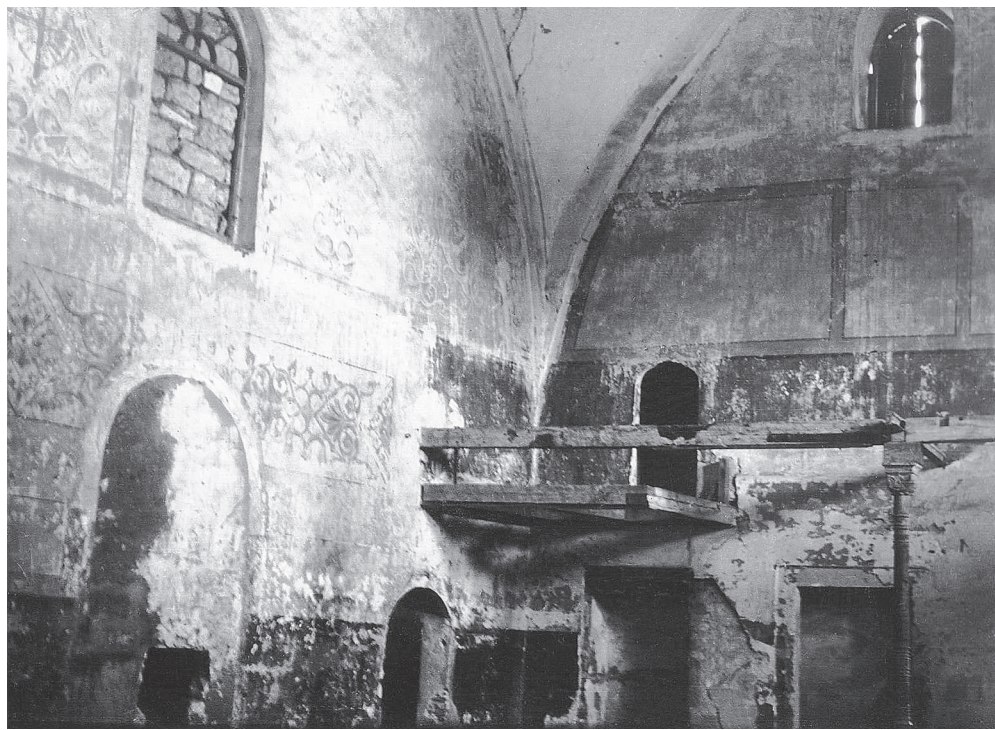
Ил. 12. Муфти-Джами. Северо-западный угол мечети. Проемы, ведущие к лестнице в толще стены. Вид с юго-востока. Фото 1966 г. (Попушинская 1966: фото 50)
