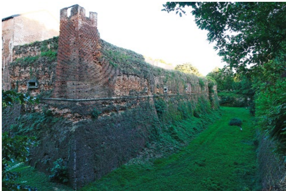
Рис. 5. Кастелло ди Новара. Башни и куртины снабжены многочисленными вытянутыми по горизонтали прямоугольными бойницами, обрамленными белокаменными плитами. Выступ угловых башен крайне мал, однако в их боковых сторонах все же встречаются бойницы для флангового огня. Фото автора, 2017 г.
