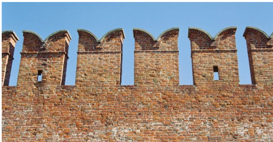
Рис. 7. Зубцы в форме «ласточкин хвост». Тульский кремль. Фото автора, 2006 г.
