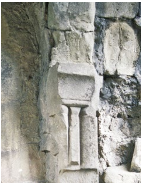
Рис. 11. Пилястра северного портала храма Джвари. Фото А. Казаряна, 2009
