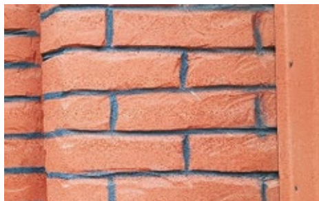
Рис. 9. Некачественная очистка кирпичных фасадов (фото А.Н. Орехова): а — доходный дом П.М. Коноваловой по ул. М. Горького, 21П; b — женская гимназия А.А. Филипповой по пер. Газетный, 82/108; c — здание фабрики по ул. Города Волос, 14
