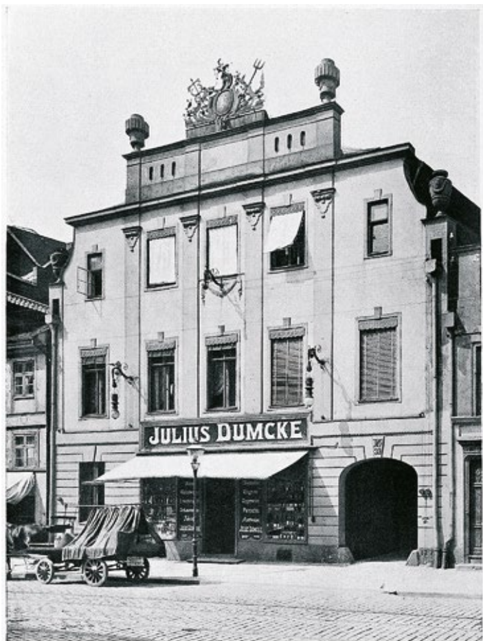
Рис. 2. Дом Думке на Фордерроссгартен, 39, Кёнигсберг (не сохранился). Ориентир — ул. Клиническая. Фотография (Rohde 1929: 122)
