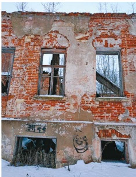
Рис. 8. Главный дом усадьбы Безобразовых. Фрагмент стены южного фасада, с закладными белокаменными деталями наличников барочного периода. Существующее состояние. Московская обл., Волоколамский район, с. Ивановское. Фото Т.В. Иванцыка, 2023 г.
