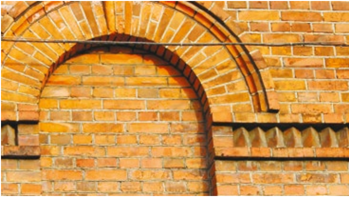
Рис. 4. Фрагмент кирпичной кладки стены здания начала XX в. Минск, Беларусь. Фото А. С. Сардарова
