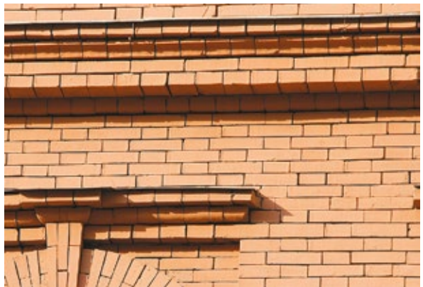
Рис. 5. Фрагмент стены здания начала XX в. После реставрации. Минск, Беларусь. Фото А. С. Сардарова
