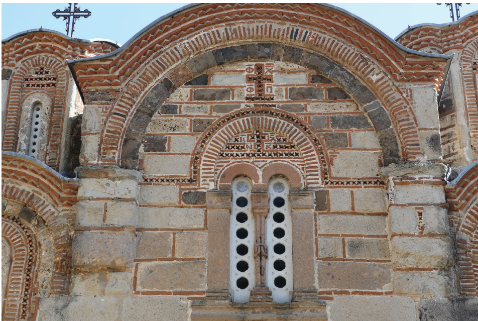
Рис. 14. Церковь Св. Георгия в Старом Нагоричине, окно западного фасада (XI в.?), встроенное в кладку при перестройке XIV в. Фото С. В. Мальцевой
